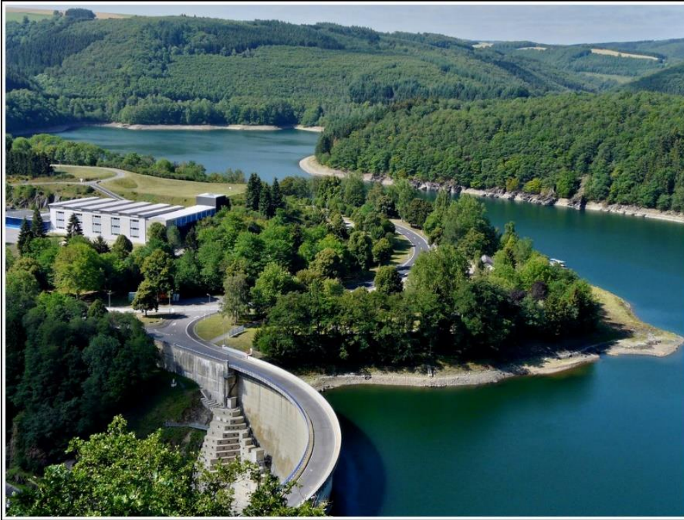
Talsperre Esch im Oberlauf der Sauer
